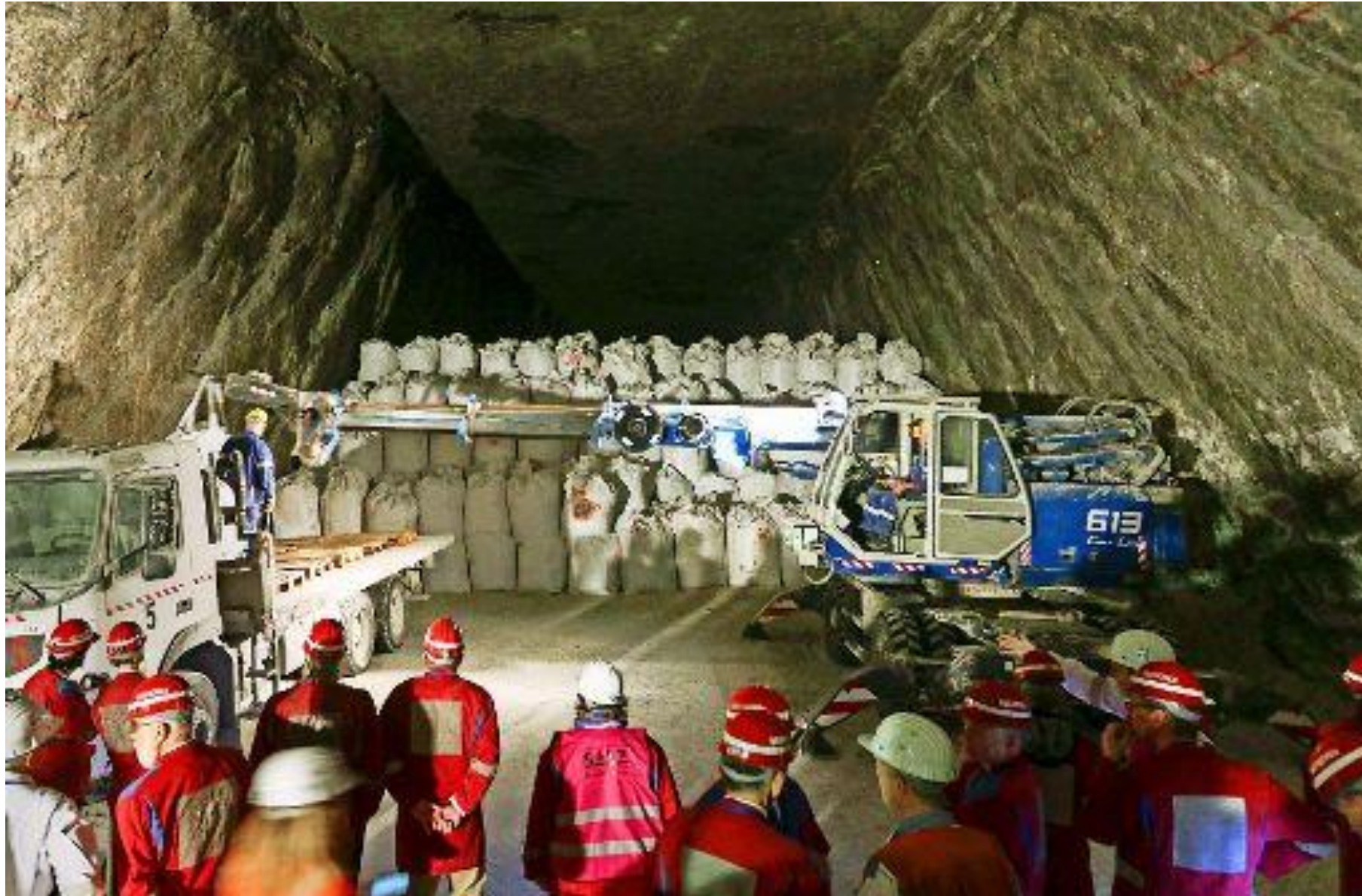
Einbau der Schlacke im Salzbergwerk Bad Friedrichshall-Kochendorf
