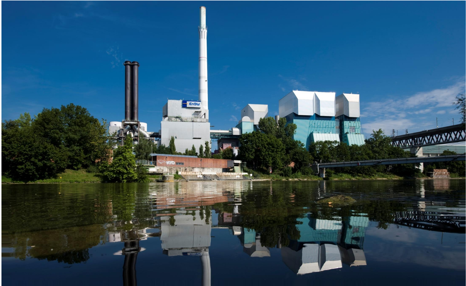
Restmüllheizkraftwerk Stuttgart-Münster der EnBW
